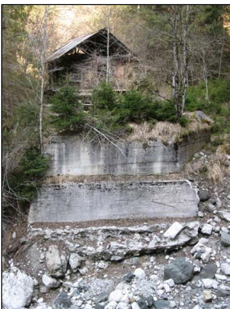
Val Vallesina: spalla di un vecchio ponte probabilmente distrutto durante l'alluvione del 1966
