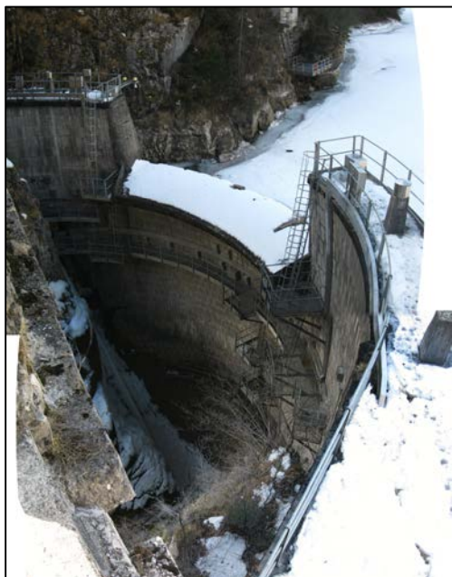
Diga a cupola di Pocroce, la cui realizzazione fu terminata nel 1951 per formare un invaso sfruttabile a scopo idroelettrico
