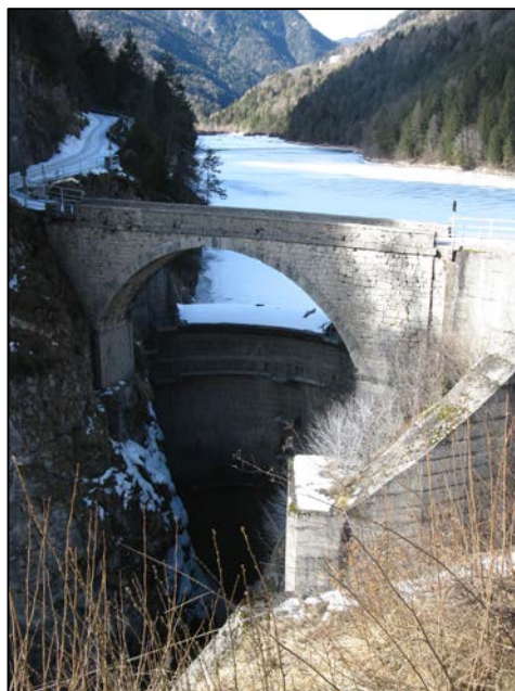
Diga a cupola di Pocroce, la cui realizzazione fu terminata nel 1951 per formare un invaso sfruttabile a scopo idroelettrico
