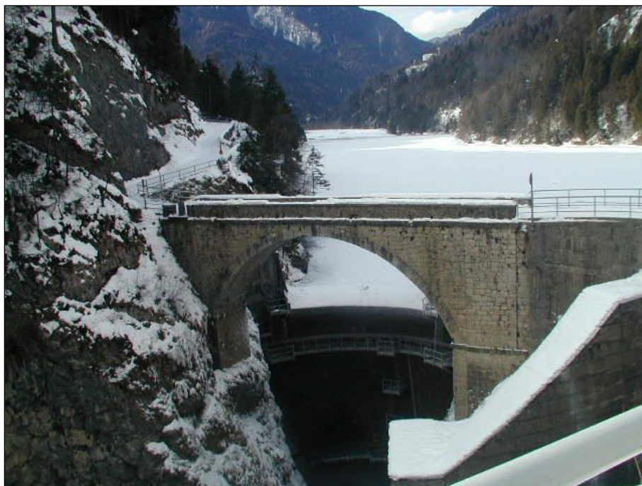
Figura 14 – Carta L'antico ponte di Pocroce lascia intravedere l'arco dello sbarramento costruito immediatamente a monte di esso.
