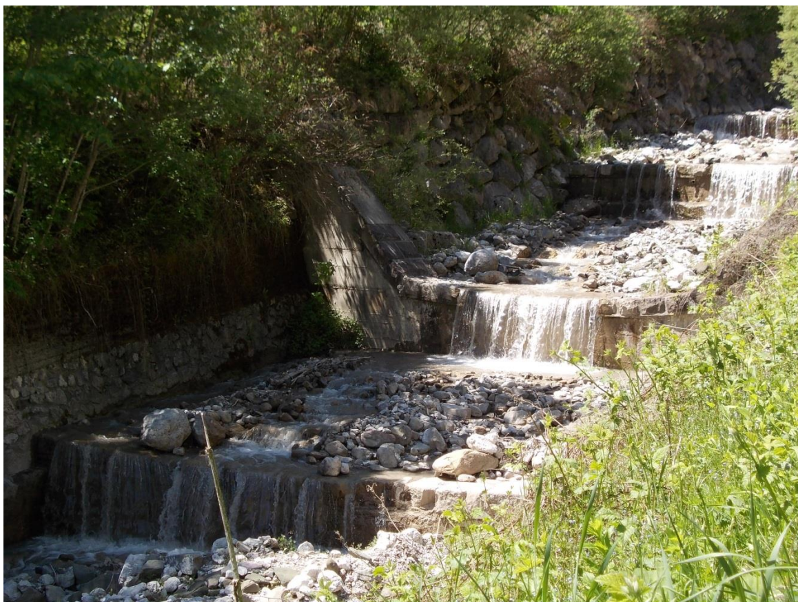
Figura 37 – Rio Vallesina – tratto sistemato con briglie classiche.
